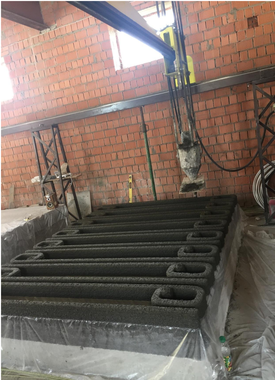
Рис. 15. Видача бетонної суміші з сопла 3D принтера для виготовлення секцій забору
