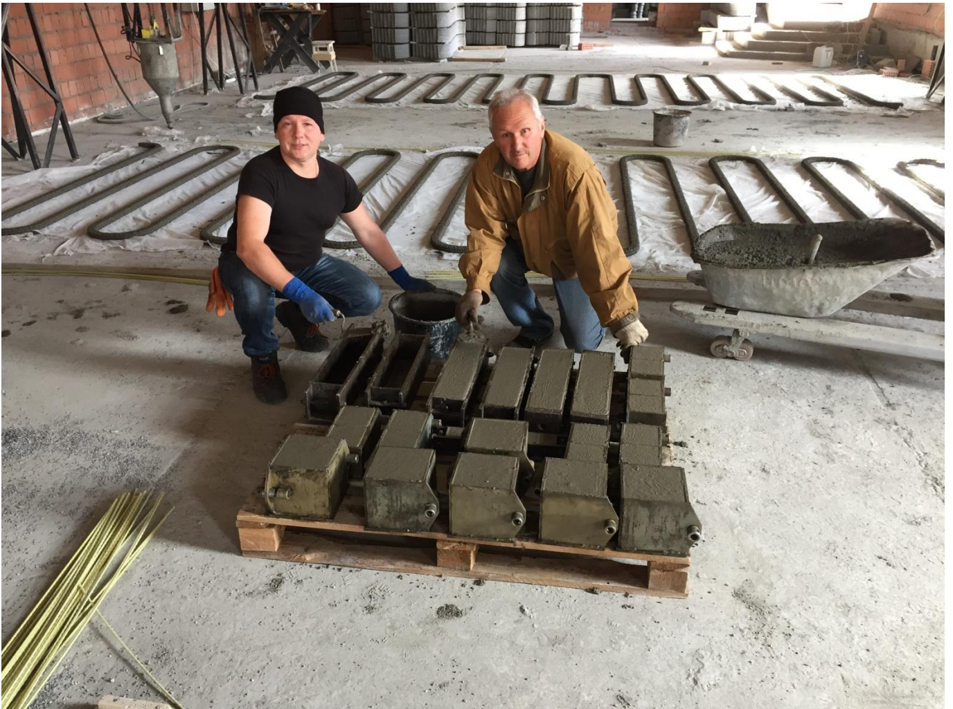
Рис. 16. Виготовлення зразків бетону в процесі удосконалення технології отримання бетонних сумішей для 3D принтеру
